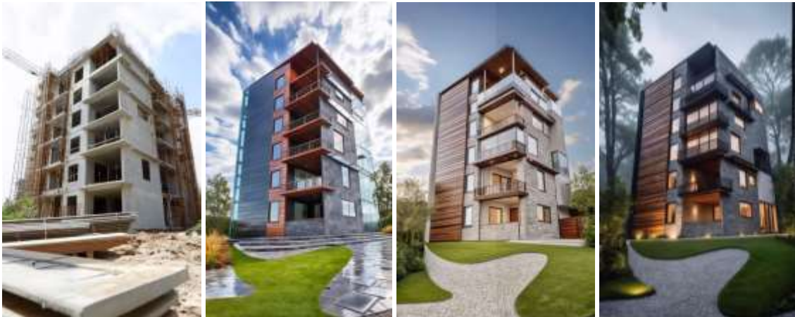
Şekil 3. İnşaat halindeki bir binanın fotoğrafı üzerinden görselleştirme (URL-3)
